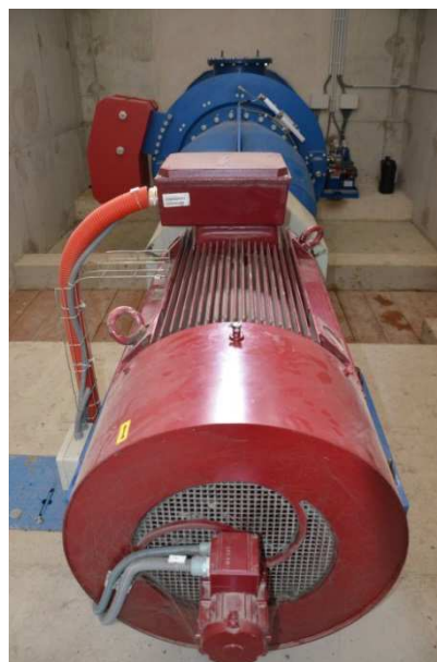
Obrázok 25 Kaplanova turbína v MVE v Lomnej
