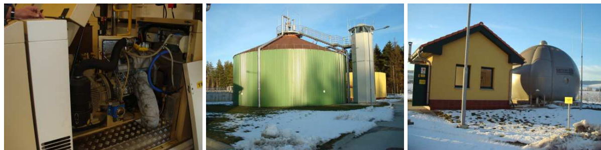
Obrázok 9 Otvorená kogeneračná jednotka, vyhrievacia veža, zásobník bioplynu
